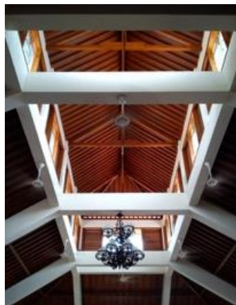
Gambar 3. Konstruksi Atap Brujung dengan Rusuk-Rusuk yang Membentuk Payung Terbuka dari Masjid Menara Kudus. Sumber : Dokumentasi Pribadi.
