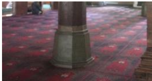
Gambar 2. Umpak atau Alas Tiang berbentuk Limasan pada Ruang Sholat Utama Masjid Menara Kudus Sumber : Dokumentasi Pribadi.
